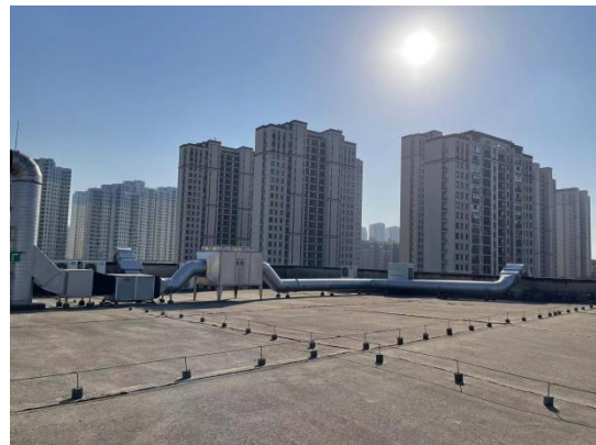
废气处理设施 9#及排气筒
