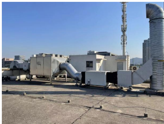
废气处理设施 8#及排气筒
