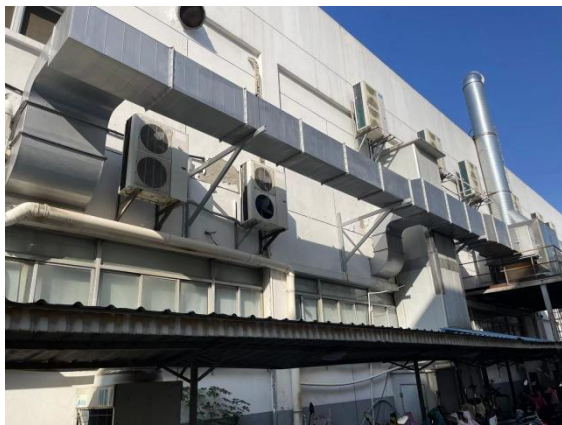
废气处理设施 2#及排气筒
